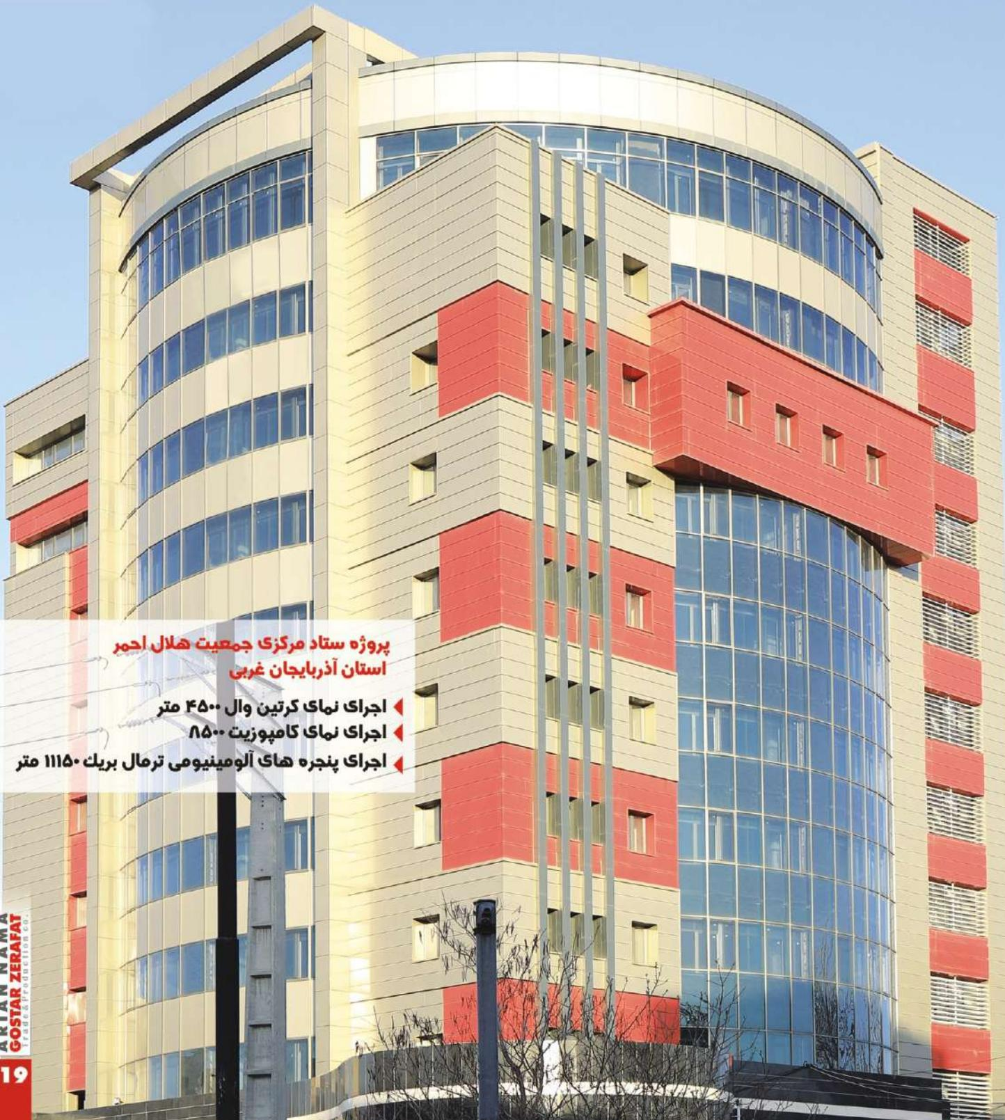
◆ طراحی و اجرای نما با ورق های آلومینیومی کامپوزیت با روش لبه دوبل و CNC همراه با مهندسی سازه زیرسازی، مهندسی برآورد مقاومت در برابر زلزله های ساختمان و تنش های استاتیکی نما
